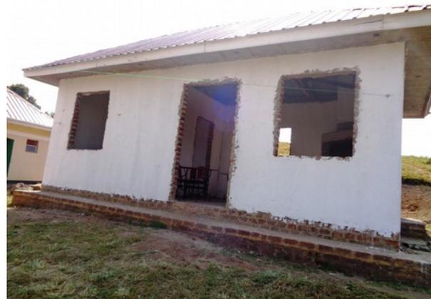
Um den Wohnkomplex der Lehrer mit zwei Wohnheimen und einer Latrinenanlage zu vervollständigen, war der Bau einer eigenständigen kleinen Küche notwendig. Der Rohbau sowie das Dach sind fertig.
